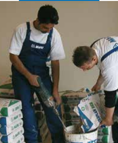
Mistura de Ultraplan Eco - Creche Mirabello di Cantù - Itália
