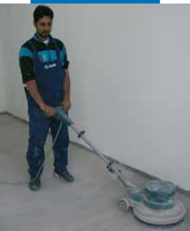
Lixagem antes da aplicação Ultraplan Eco - Creche Mirabello di Cantù - Itália
