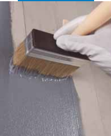
Aplicação do Eco Prim Grip a pincel sobre suporte em betão
