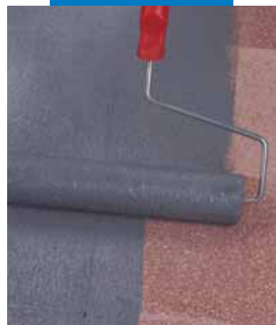
Aplicação de Eco Prim Grip a rolo sobre uma velha pavimentação em mármore
