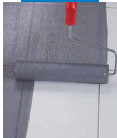
Aplicação de Eco Prim Grip a rolo sobre uma pavimentação em ladrilhos de grés porcelânico pré existente
