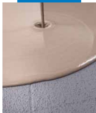
Aplicação da argamassa de regularização autonivelante Ultraplan sobre o Eco Prim Grip enxuto e aplicado sobre um velho pavimento
