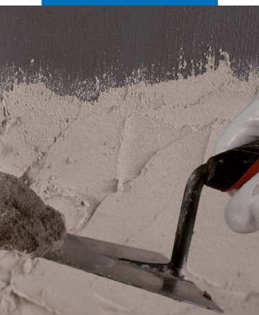
Aplicação de reboco sobre Eco Prim Grip Plus
