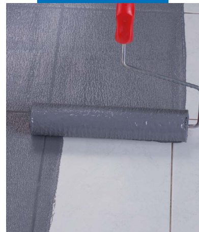
Aplicação a rolo de Eco Prim Grip Plus sobre pavimento existente em ladrilhos de grés porcelânico
