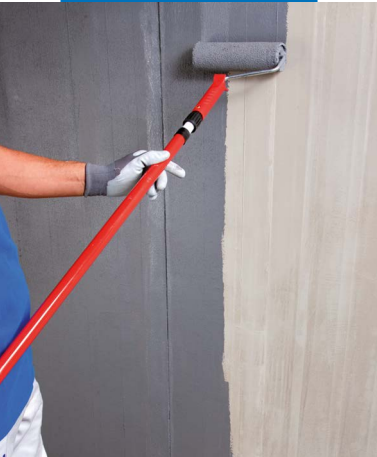
Aplicação de Eco Prim Grip Plus a rolo sobre suporte em betão
