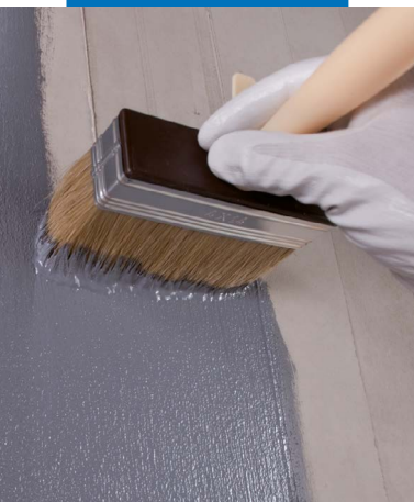
Aplicação de Eco Prim Grip Plus com pincel sobre suporte em betão
