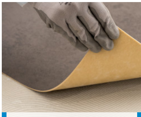
Aplicação de pavimento de base poliuretânica com Ultrabond Eco V4 Evolution
