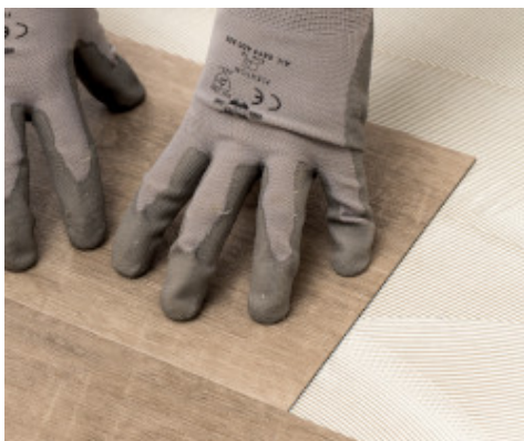
Aplicação de LVT com Ultrabond Eco V4 Evolution
