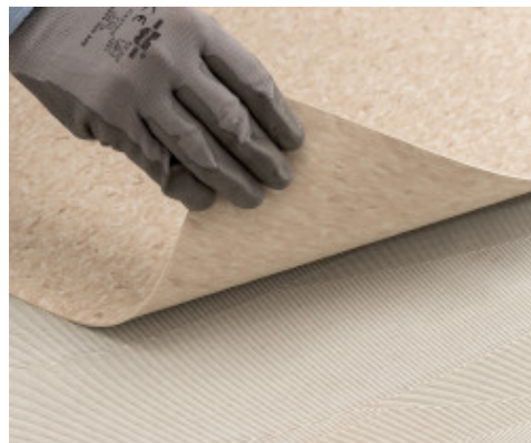
Aplicação de PVC homogêneo com Ultrabond Eco V4 Evolution
