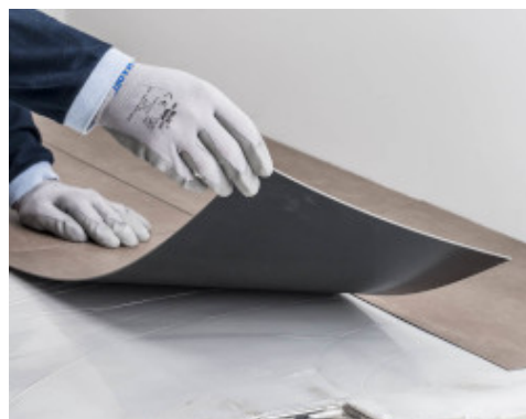
Aplicação de LVT em piso com Ultrabond Eco MS 4LVT Wall&Floor em áreas molhadas
